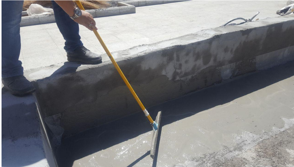
شکل ۴: اجرای عایق رطوبتی همراه با مش الیاف شیشه در گوشه ها
