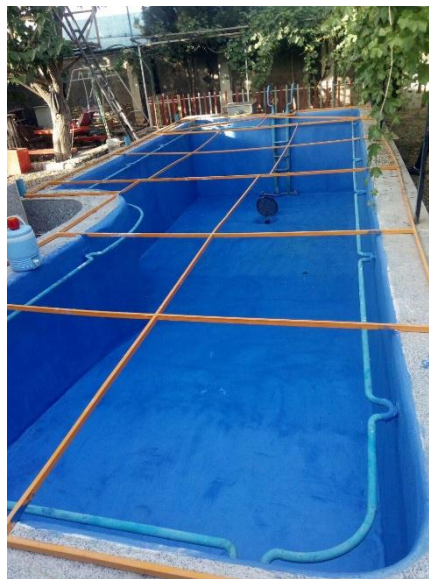
شکل ۱- نمونه اجرای عایق رطوبتی پرین
