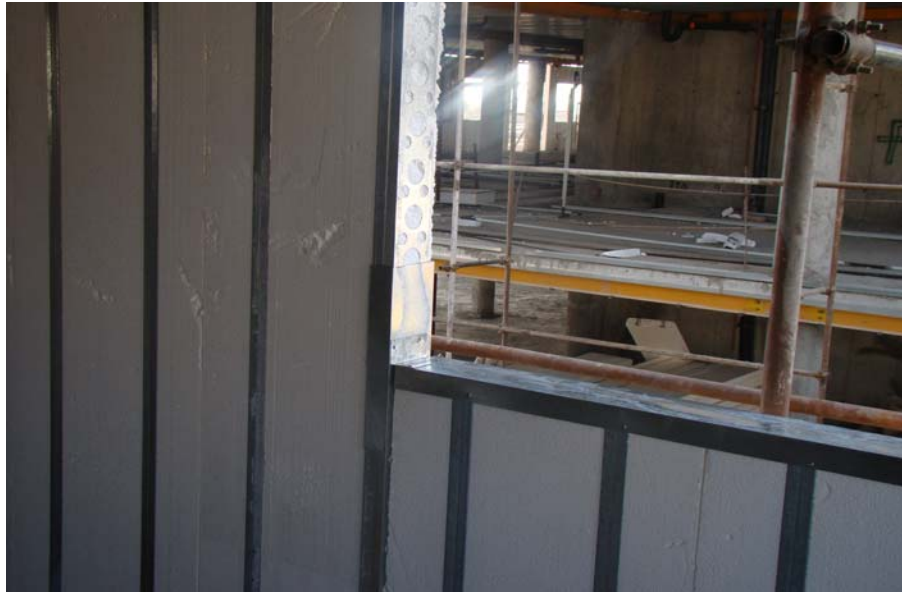
تصویر شماره ۳ : اجرای پنجره
