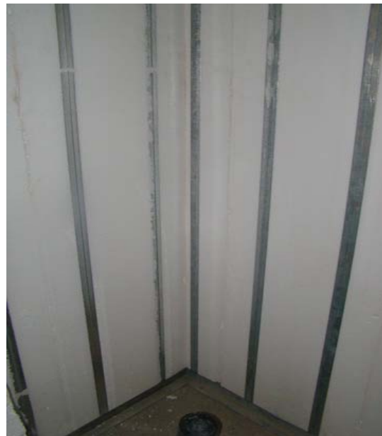
تصویر شماره ۲: اجرای دیوار کنج
