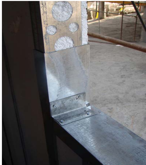
تصویر شماره ۴ : اجرای پنجره
