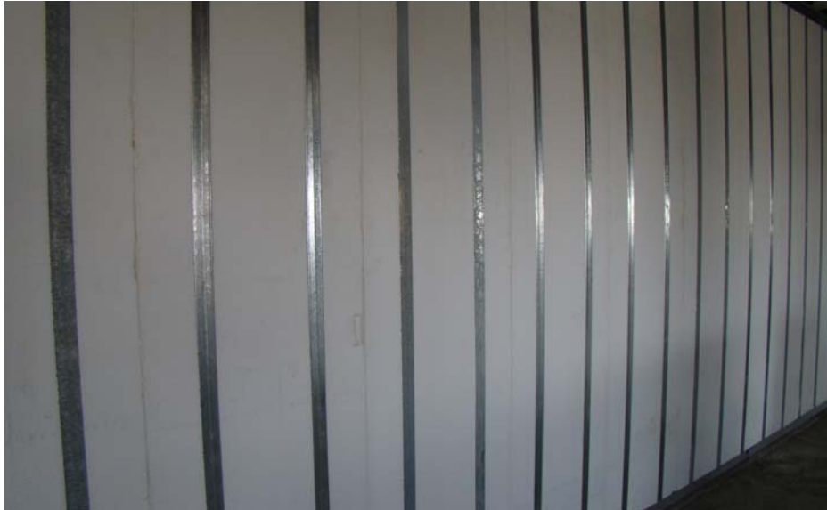
تصویر شماره ۱: اجرای دیوار راسته
