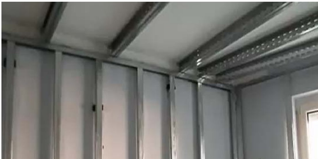
شکل ۳: پایه های نصب عایق
