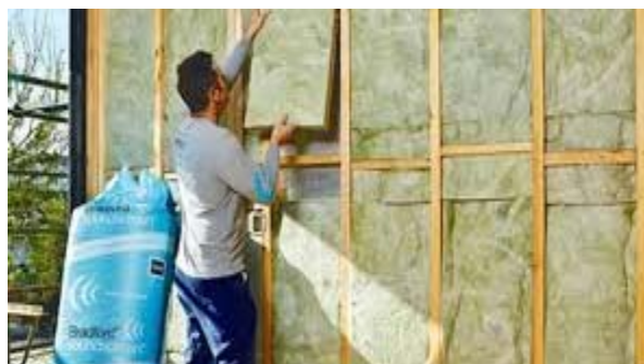
شکل ۴: جا زدن پشم سنگ در پایه ها
