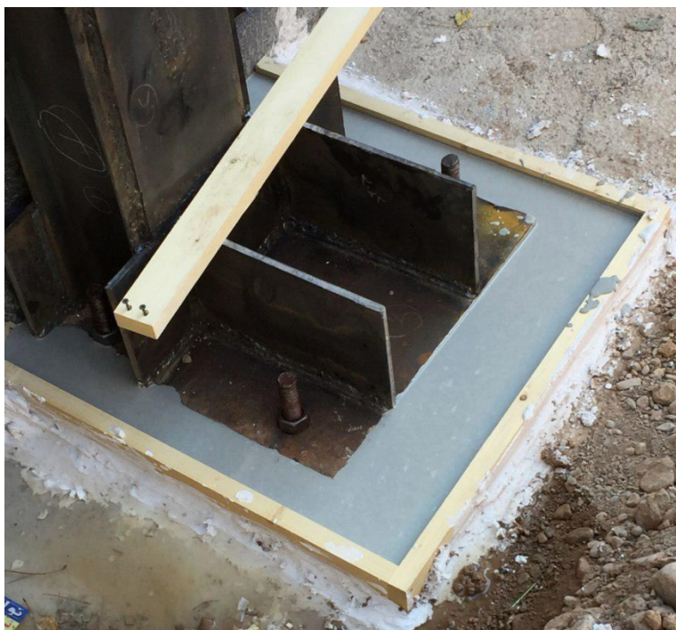
شکل ۱- نمونه اجرای گروت صنعتی
