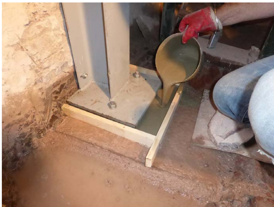
شکل ۲- گروت‌ریزی در قالب دور کف ستون
